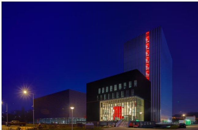
Elektrificatie bedrijven en industrie
